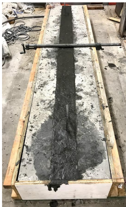
Figure 2.15 Deck Panels after UHPC pour
